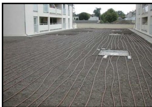
FIGURE 6.6 – Exemple de goutteurs en ligne installés pour une toiture végétalisée (Source : sirev.fr )
