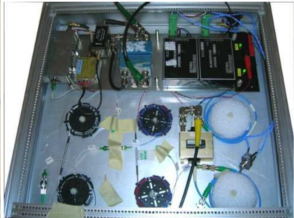
Mise en rack
